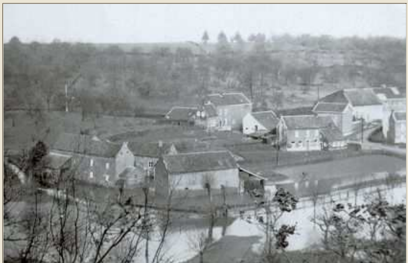
La Julienne sortie de son lit, occupe l'emplacement du talus de l'autoroute actuelle. Le moulin de Saivelette est à gauche.
