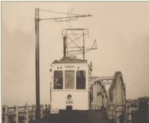
Le tram franchissant le nouveau pont
